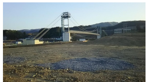
コンベア橋は、解体工事中（陸前高田）
